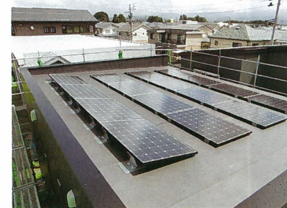
磁石で太陽光発電パネルを取り付ける「マグソーラーシステム」
