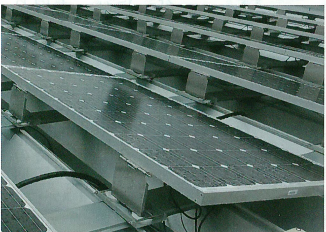
サン・エナジールーフシステム設置施工例 (背面側)
