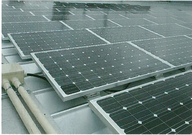
サン・エナジールーフシステム設置施工例 (前面側)
