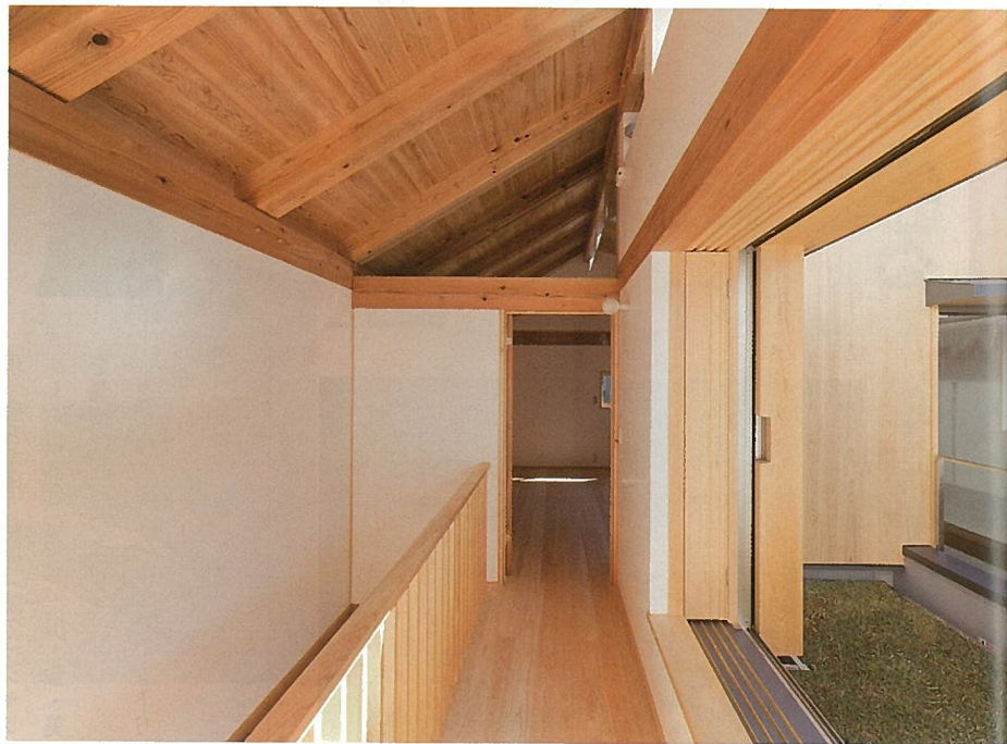
2階廊下。燃え代設計により、通常よりひとまわり太い柱・梁。窓を開け放つとバルコニー（屋上緑化）とひと続きに
