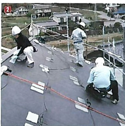
①(マグソーラーシステム)金属加工を施した屋根に強力なマグネットで固定する ②4kWの設備なら施工に要する時間は半日 ③今年11月にマグソーラーシステムを導入した森本邸
