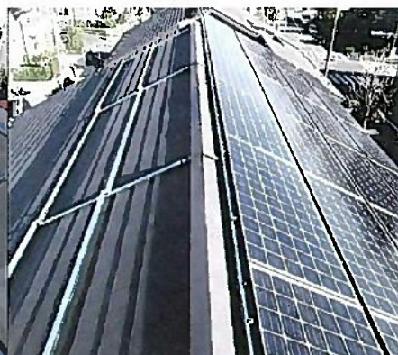
パネルを設置する側の反対の屋根にバランスをとるための架台を設置
