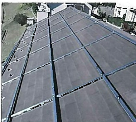
〈シンプル・レイ工法〉格子状の架台のピッチを変更することで、全メーカーのパネルに対応可能
