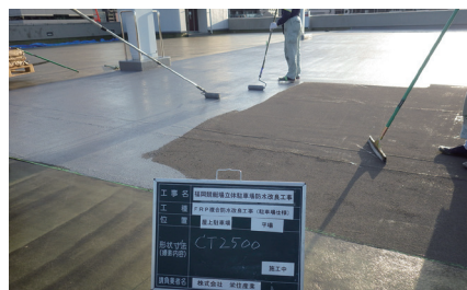
施工中の様子
