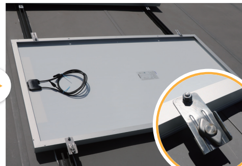
3 太陽光パネルに架台金物を取り付ける
