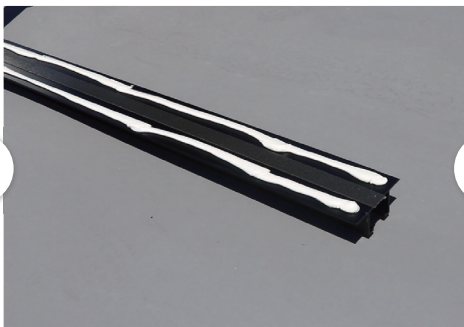
2 レールの裏面に専用テープと専用接着剤を塗布し墨付け箇所に設置する
