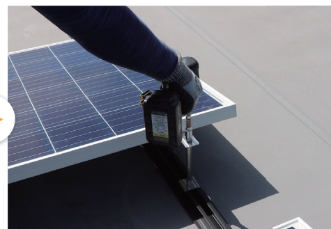
6 接続部分をボルトで固定する
