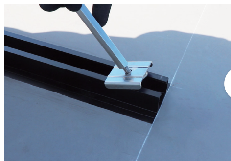
4 スライドレールのパネル起こし側に高さ調整ボルトを仮付けする
