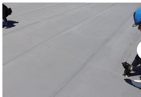
1 スライドレール取付け位置を墨付けする
