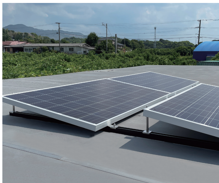
4 スライドレールのパネル起こし側に高さ調整ボルトを仮付けする
